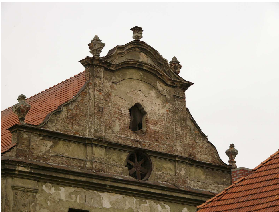
Obr. 10: Litomyšl – Nedošín, Štít sýpky tzv. Pernštejnského dvora. Foto: Vladislava Říhová.
